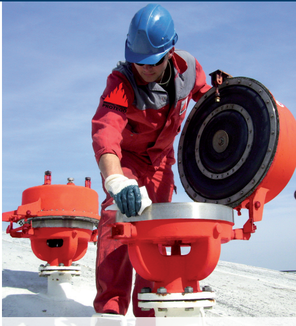
Flammdurchschlagsicherungen warten
