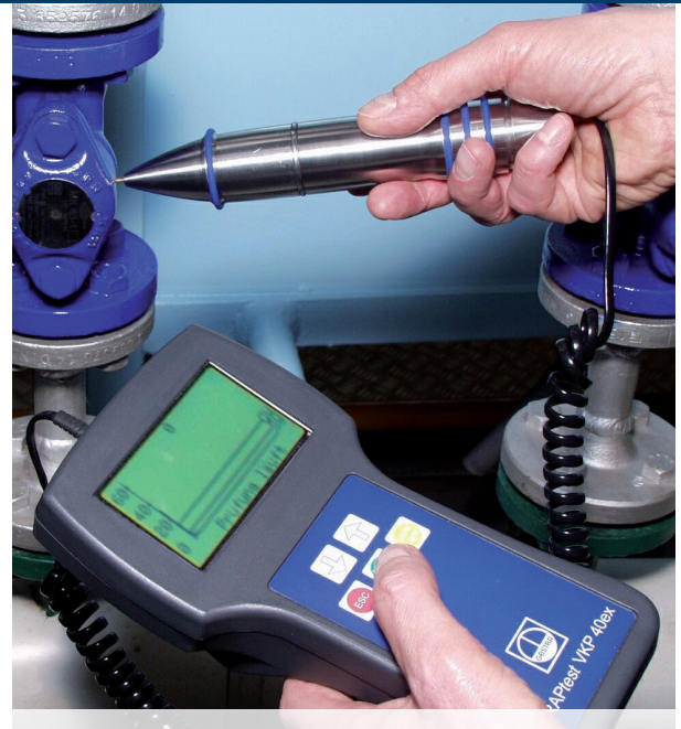
Kondensatableiter messen
